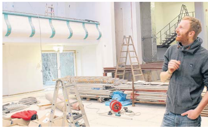
Lutz Grabowski und Kathrin Frese freuen sich über den zügigen Baufortschritt.
